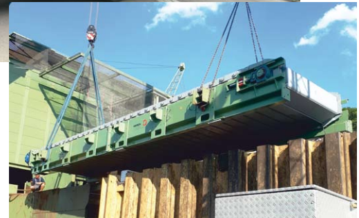
Das Plattenband, noch ohne montierte Seitenwände, wird von zwei 55-Tonnen-Autokränen in seine endgültige Position gehoben
