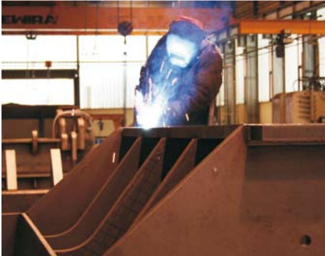
Bei Metso Lindemann werden alle Maschinenkomponenten selber gefertigt und – wie hier zu sehen – verschweißt
