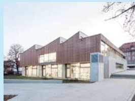
Null-Energie-Fachklassentrakt, Liebel/Architekten BDA & Transsolar Energietechnik GmbH & Stadt Aalen Foto: IDZ | Liebel/Architekten BDA
