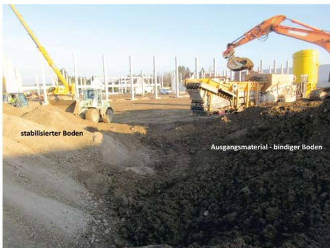
Bodenstabilisation mit der Sieb- und Mischmaschine 3-mtbc
