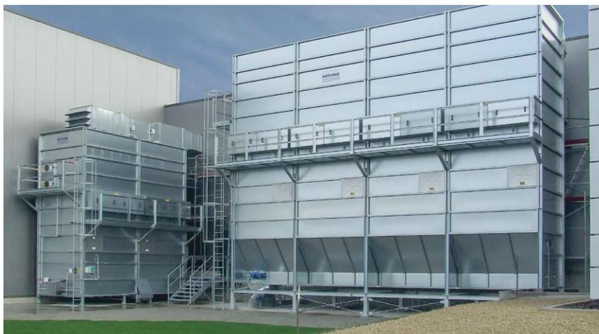
Zwei MultiStar Filteranlagen liefern den Unterdruck für die Entsorgung
