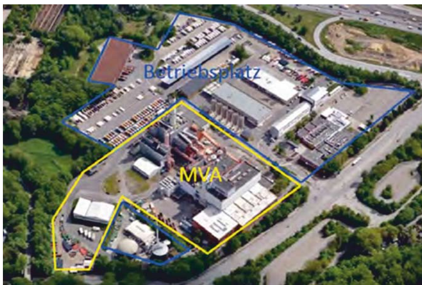
Gelände der ehemaligen MVA Stellingher Moor. Auf dem gelb umrandeten Anlagenareal wird das ZRE gebaut
