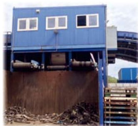
Be- & Entlüftung von Sortierkabinen
