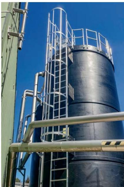
Steigleitern sorgen für den sicheren und schnellen Zugang auf Dächer, Anlagen und Silos
