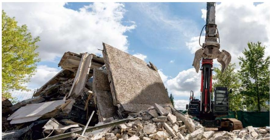
Heidelberg Materials setzt Altbeton aus dem Rückbau sowohl in der Herstellung von neuem Beton und Betonwaren als auch bei der Herstellung von Zement ein
