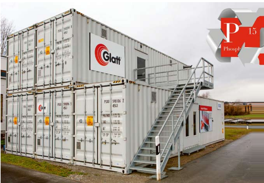
Containeranlage zur Schwermetallabreicherung von Klärschlamm-Aschen
