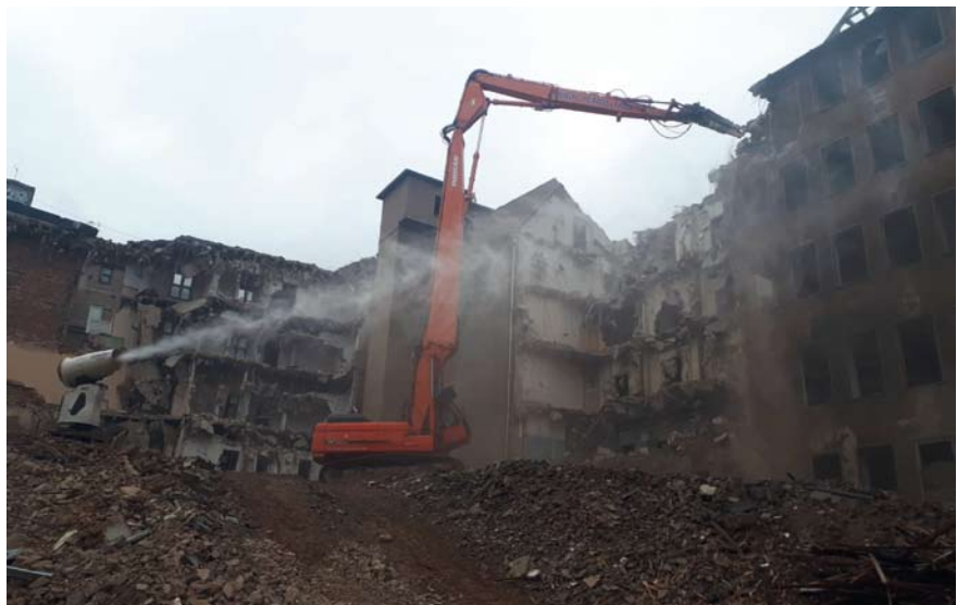
Anfang 2019 wurde mit dem Hotelabbruch in Leipzig begonnen, eine technische Herausforderung, da das Gebäude unter Denkmalschutz steht und die Fassade erhalten werden muss. Die Abtragung begann somit rückseitig. Zur Staubvermeidung und Staubbinderung ist eine Staubbindermaschine V125 von Neborex Umwelttechnik im Einsatz
