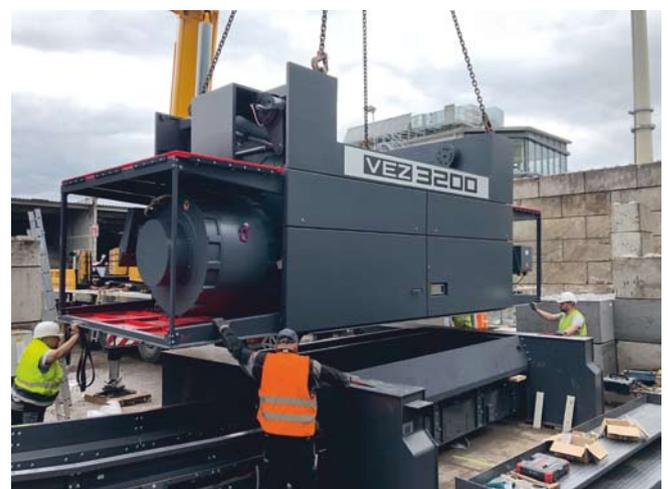
Für die Anlagenerweiterung installierte Vecoplan einen zusätzlichen Einwellen-Vorzerkleinerer der Baureihe VEZ 3200, der das Material kleiner 250 Millimeter schreddert
