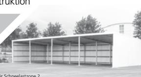
ausgelegt für Schneelastzone 2, Windzone 2, Schneelast: 85kg/m²
