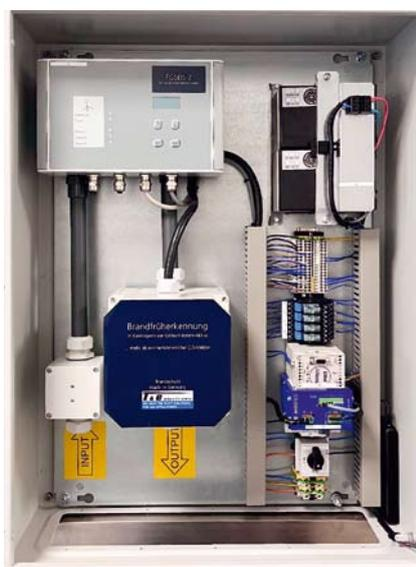
Smartes System zur Brandfrüherkennung in Kleinlagern von Lithium-Ionen-Akkus
