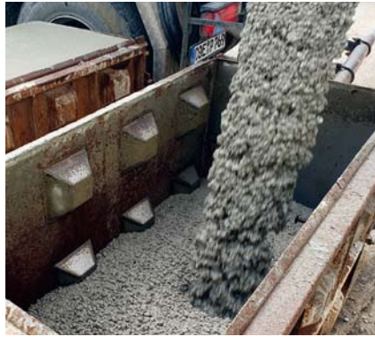
Herstellung von Beton-„Legosteinen“ im Transportbetonwerk unter Verwendung von SWS
