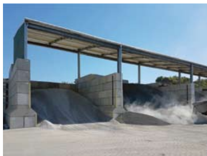
Pultdachhalle als Überdachung für Schüttgutlager
