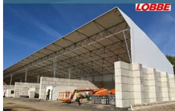
Pulthallen auf Betonblocksteinen
