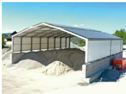
Satteldachhalle mit PV-Anlage als Baustofflager
