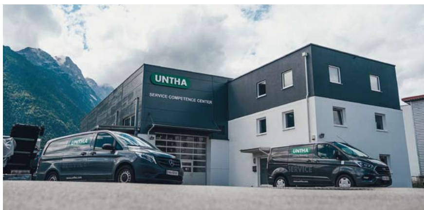
Das Untha Service Competence Center wurde an einen neuen Standort verlagert und modernisiert
