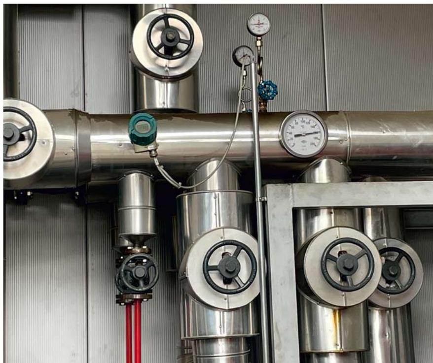
Der Sitrans TS500 sorgt hier im Heizraum von Bottari und während des gesamten Ölabscheidungsprozesses für eine genaue Temperaturüberwachung
