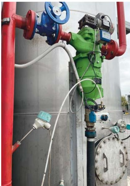
Ein zuverlässiges Füllstandsmesssystem für die Lagertanks von Bottari, die der Anlage vorgeschaltet sind: Druckmessumformer Sitrans DSIII, Temperaturüberwachung Sitrans TS500 und Hoch- und Tiefalarmierung mit Sitrans CLS100
