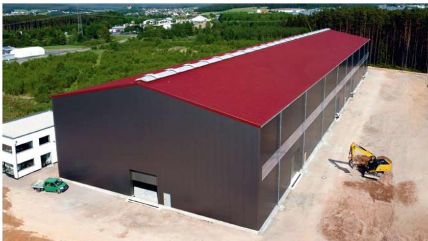
Die Dimensionen dieser Recyclinghalle sind wirklich beeindruckend und markieren einen Meilenstein im Portfolio von HÖRMANN. Die Halle besteht aus einer Stahl-Brettschichtholz-Konstruktion. Die Bauteile wurden im Werk am Stammsitz von HÖRMANN in Buchloe im Allgäu gefertigt. Mit einer imposanten Länge von 136 Metern, einer Breite von 36 Metern und einer Gesamtfläche von 4.896 Quadratmetern bietet die Halle großzügigen Raum für effiziente Recyclingprozesse.
