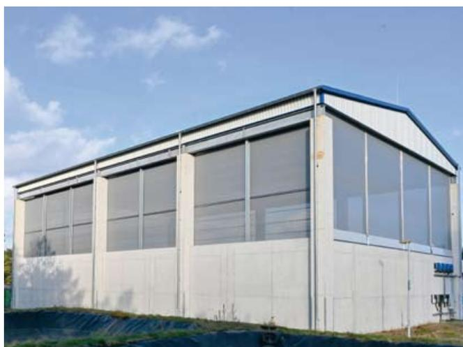
Tectura Textile Fassaden an der Restmüllhalle
