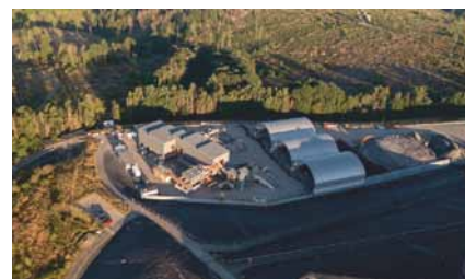
Anlage für die Aufbereitung von Rostaschen am Entsorgungszentrum Leppe in Lindlar
