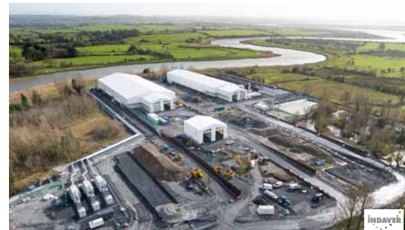
Überdachung für Boden-sanierungen
