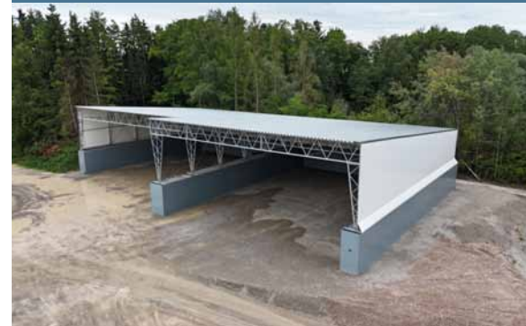
Pulthallen mit Trapezblechverkleidung
