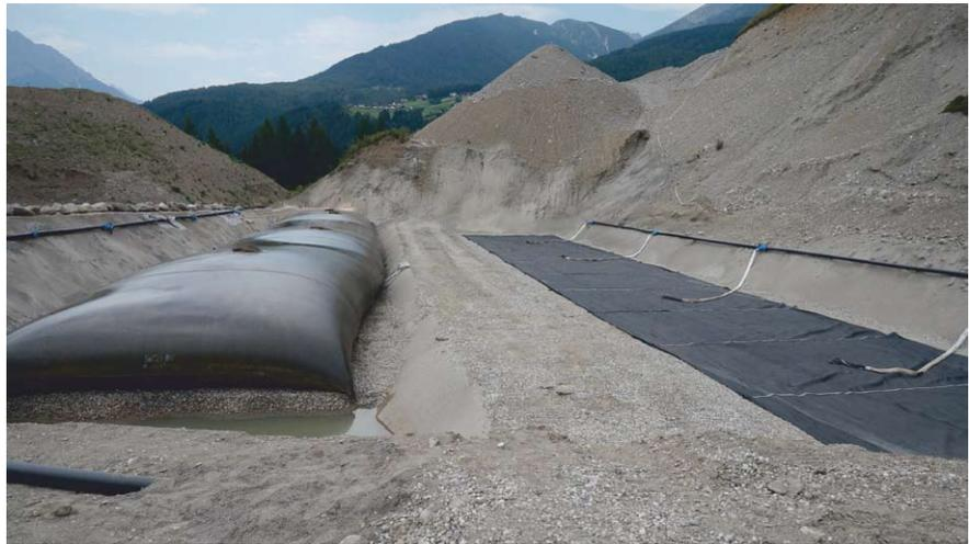
Entwässerungsbecken mit teilgefülltem Schlauch (links) und zur Befüllung mit ausgelegtem Schlauch (rechts)
