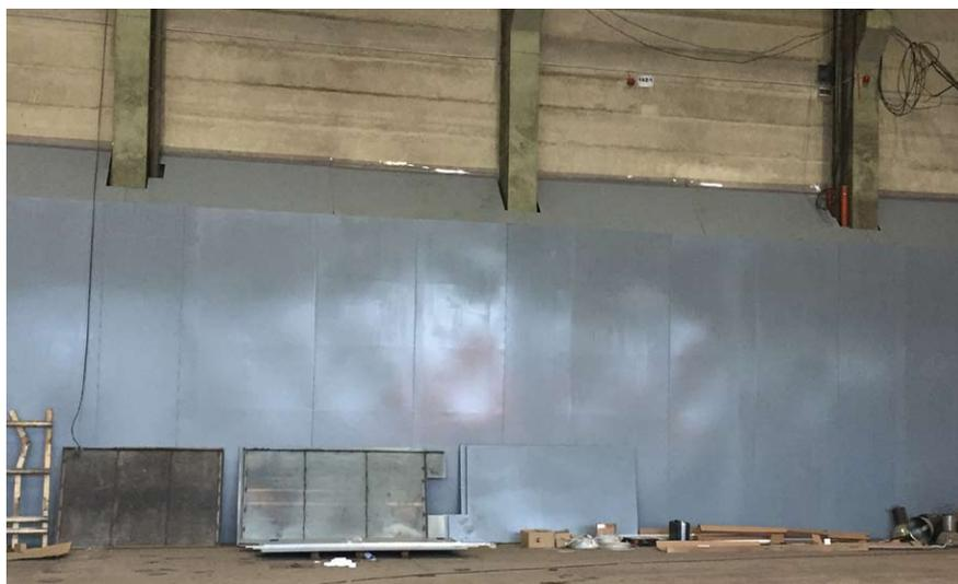
Hallenstützen werden passgenau durch LÜRA-Stellwände eingefasst und geschützt
