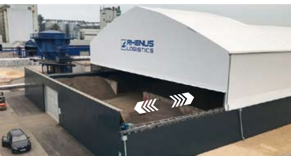
Sonderbauten (z.B. Verschiebbare Dachkonstruktion)
