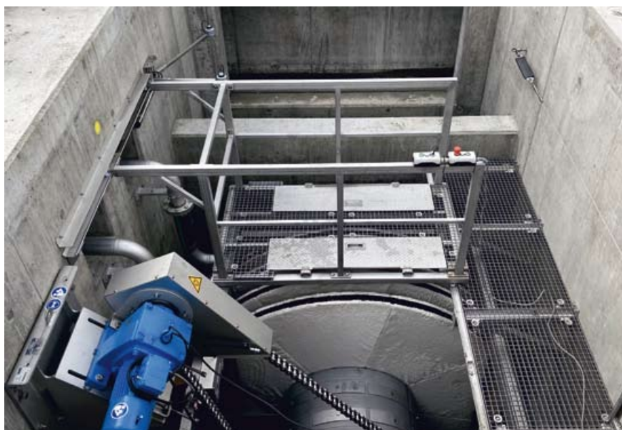
Flockungsfiltration mit dem HUBER Tuchfilter RotaFilt® 2700 auf der Kläranlage Kreßberg
