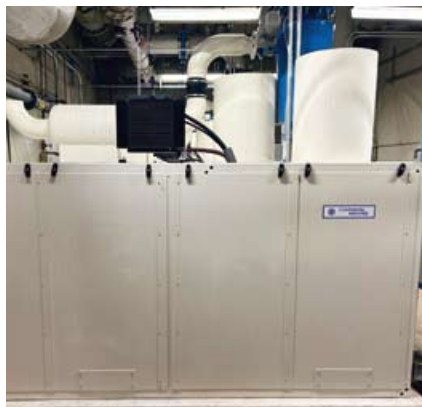
Turbokompressoren von Continental Industrie werden für den Klärbetrieb bei Bedarf auch gleich fertig eingehaust
