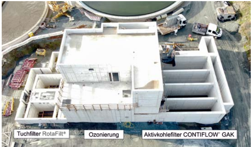
Der Neubau der vierten Reinigungsstufe in Bickenbach schreitet zügig voran
