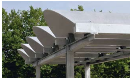
Carbonbeton heute: dünnwandige gekrümmte Tonnen-schalen als Dachelemente am ITA
