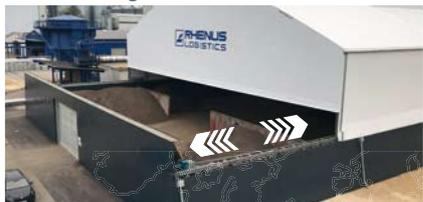
Sonderbauten (z.B. Verschiebbare Dachkonstruktion)
