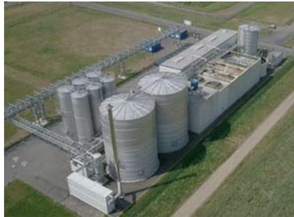
KS-Recycling GmbH & Co. KG (KSR) in Sonsbeck installiert. Diese ermöglicht die Vorreinigung hochgradig verschmutzter Rohabwässer aus der Altöl-, Kühler-, Bremsflüssigkeits- und Lösemittelaufbereitung. Die Ergebnisse der Probenahme zeigten eine Reduzierung des TOC-Gehalts um den Faktor 10 und eine effektive Abscheidung von Schwermetallen. Somit
