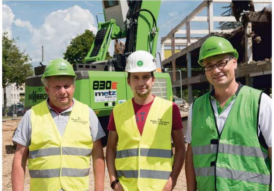
Abbruch-Projektteam in Regensburg (von links): Albert Metz, Christian Metz (Geschäftsführer Metz Erdbau GmbH) und Michael Bauer (Sennebogen)
