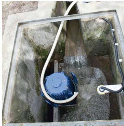
Eine Ultraschall-Füllstandsmessung (rechts an der Schachtwand) schaltet den Zerkleinerer abhängig vom Wasserstand ein und aus. Vom Regenüberlaufbecken führt ein offener Kanal zum Zerkleinerer
