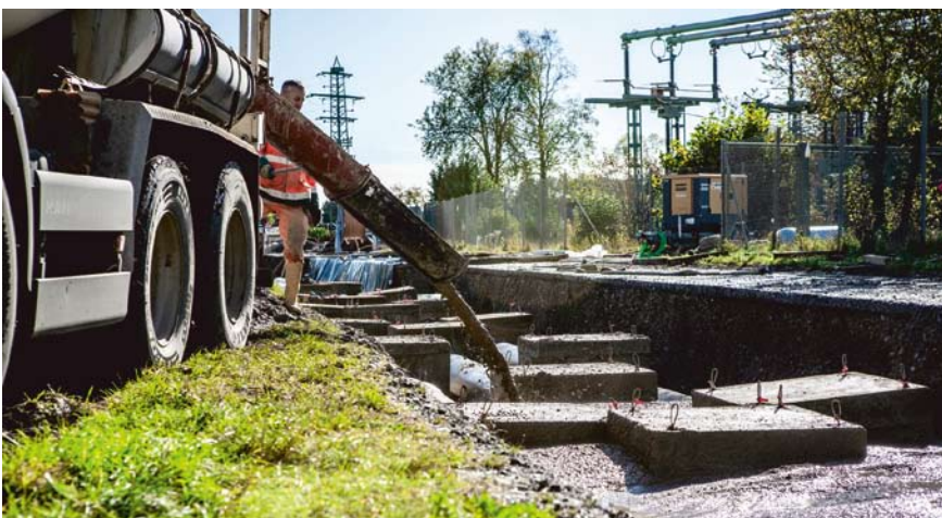
Die Leitungen des Fernwärmenetzes Memmingen werden mit dem Flüssigboden von Max Wild verfüllt
