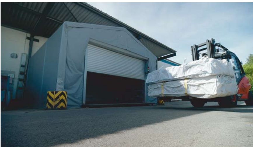
Beschickung der Materialschleuse des stationären Sanierungsbereichs
