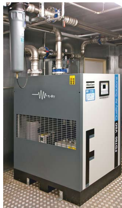
In den Sommermonaten stellt ein drehzahl geregelter Kältetrockner vom Typ FD 760 VSD einen Drucktaupunkt von +3 °C sicher
