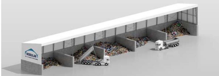
Pulthallen auf Betonblocksteinen
