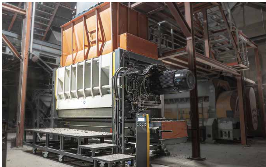
SR3000XC erfolgreich bei Korn im Einsatz
