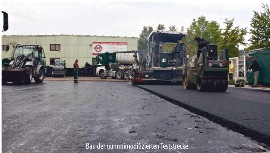
Bau der gummimodifizierten Teststrecke
