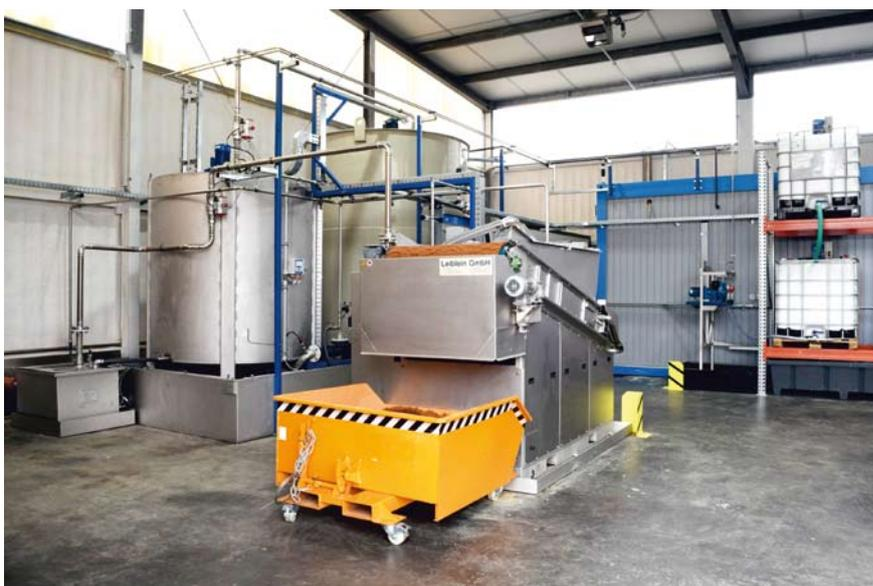
Die Leiblein Abwasser-Reinigungsanlage bereitet das Beizabwasser so auf, dass ohne weiteres die Zuführung in die öffentliche Kanalisation erfolgen kann
