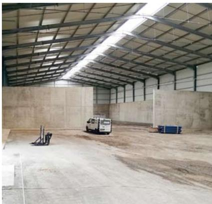
als freitragende Stahlhalle (110 x 40 m) auf einer sechs Meter Ortbetonwand.
