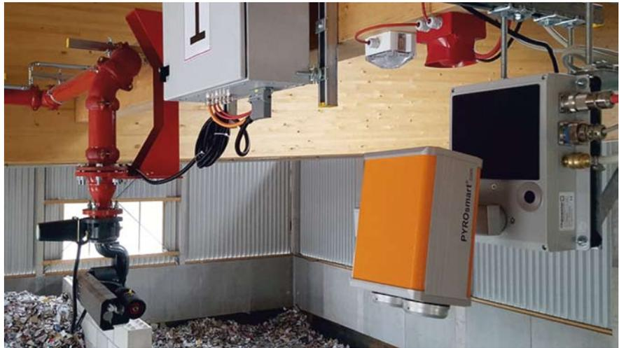
PYROsmart mit angebundenem Löschwerfer in einer Recyclinghalle
