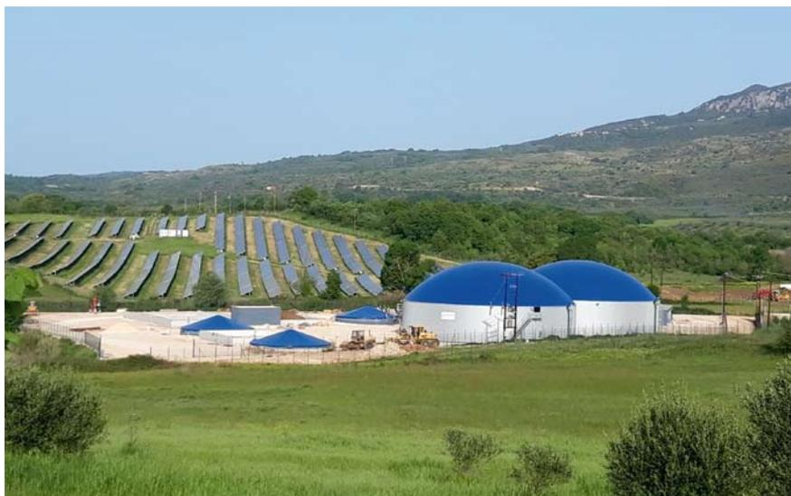
ßend Rührwerke das Mischen der Substrate für eine effiziente Biogasproduktion. Die zwei Fermenter in Arta fassen jeweils 4.436 Kubikmeter, in Ioannina steht ein 3.993-Kubikmeter-Fermenter, und der Behälter in Serres misst 4.905 Kubikmeter. „Alle Tanks bestehen aus hochwertigem Edelstahl“, konkretisiert der verantwortliche Verfahreningenieur bei Weltec Biopower, Tobias Peuker. Nach seiner Aussage kann anschließend auch der Gärrest mit seinem hohen Nährstoffgehalt als Dünger genutzt werden.
