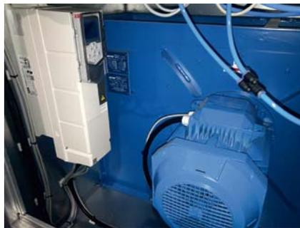
Die ABB-Hochwirkungsgradpakete bestehen aus einem IE5-Synchronreluktanzmotor und einem Frequenzumrichter ACS580, die optimal aufeinander abgestimmt sind
