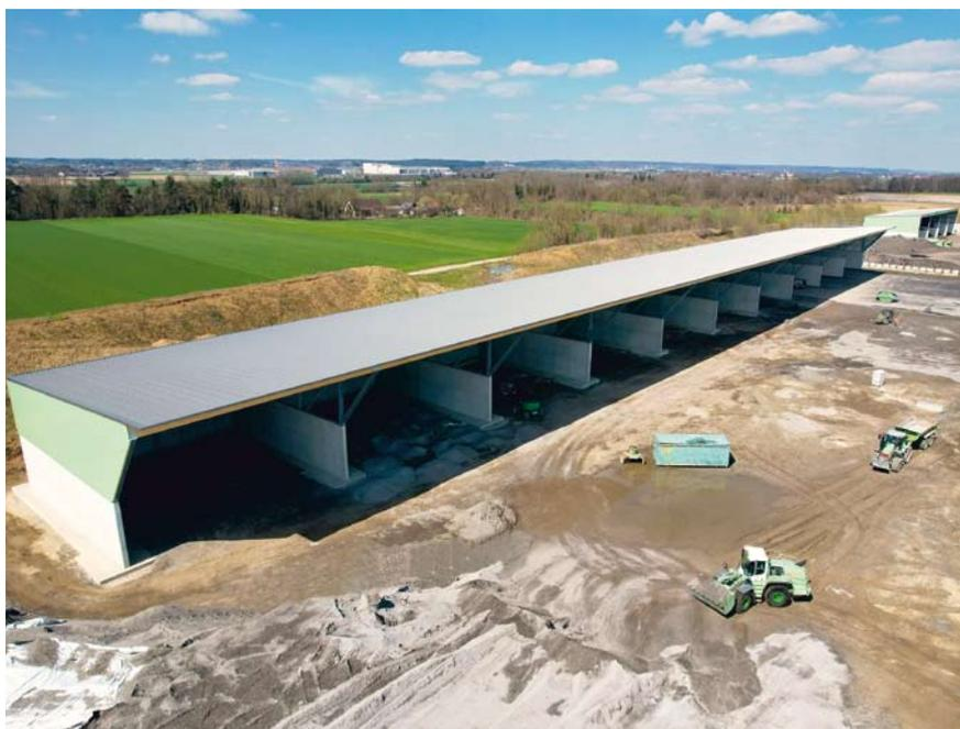
Diese Pultdachhalle hat mit einer Breite von 20 Metern und einer Länge von 200 Metern beeindruckende Ausmaße und wurde kürzlich an einem Baustoff-, Recycling- und Entsorgungsstandort in der Nähe von Memmingen errichtet. Auffallend bei dieser Halle ist das acht Meter lange Vordach, das einen geschützten Vorbereich ermöglicht. Es ermöglicht den Umschlag von Materialien vor der Halle, unabhängig von Wetterbedingungen.
