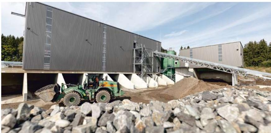
Die Bodenwaschanlage von Max Wild recycelt mineralische Bauabfälle und arbeitet sie zu zertifizierten Sekundärbaustoffen auf
