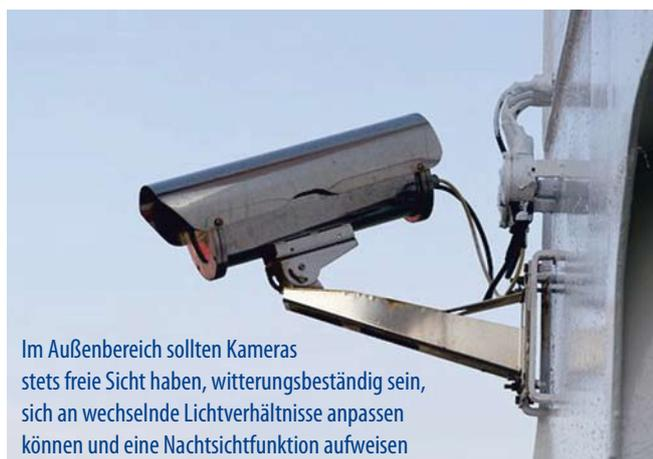
Im Außenbereich sollten Kameras stets freie Sicht haben, witterungsbeständig sein, sich an wechselnde Lichtverhältnisse anpassen können und eine Nachtsichtfunktion aufweisen
