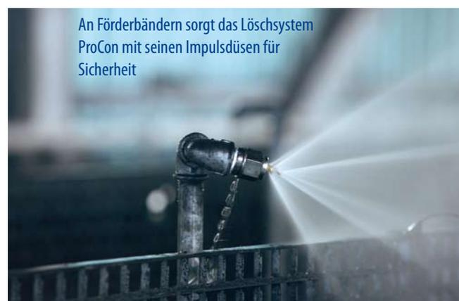
An Förderbändern sorgt das Löschanlage ProCon mit seinen Impulsdüsen für Sicherheit
