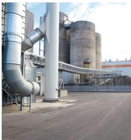
Der 420 Meter lange Rohrgurtförderer bei B+T Deuna, der die EBS-Anlage mit dem Zementwerk verbindet, trägt entscheidend zum Erfolg bei
