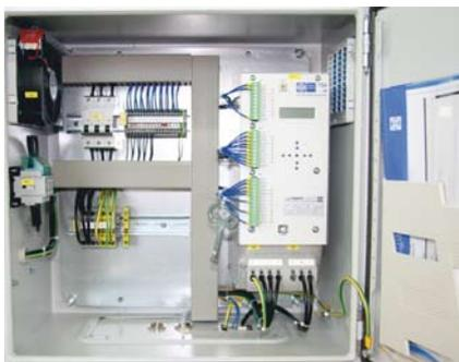
gerät bei den sicherheitsrelevanten Funktionen den Performance-Level „PL-d“. Das haben wir technisch realisiert, in dem das Umpol-Steuergerät mit Safety-Ausgängen nach EN ISO 13849 in Kategorie 3 ausgerüstet wurde. Dazu wurde neben den vorgeschriebenen Bauteilen ein zweiter
