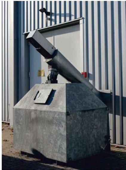
Aschecontainer für Rostasche der 1.000-kW-Strohheizungsanlage Gülzow
